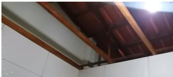
Figura 5 - Imagem ilustrativa barroteamento forro de PVC.
