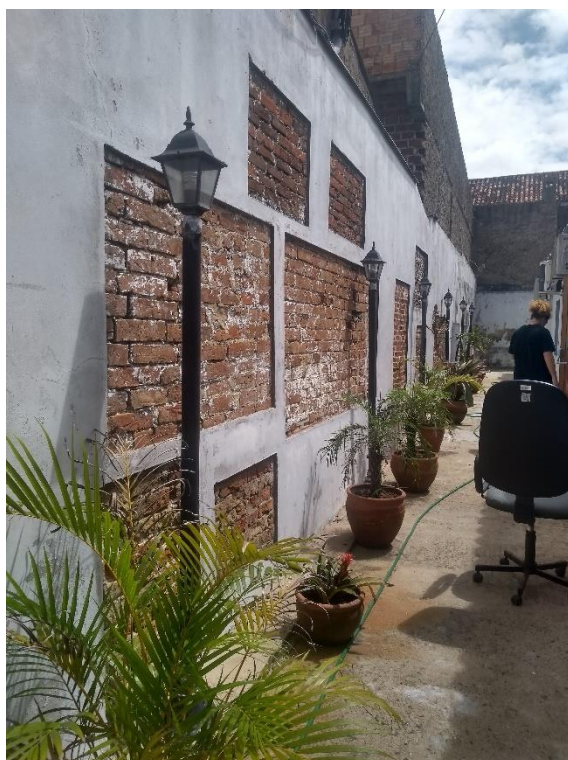
Foto 3 – Luminárias a serem pintadas.
