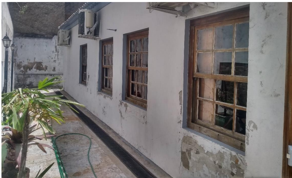
Foto 1 – calha lateral onde serão substituídos os canos de PVC.
