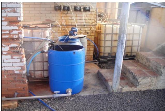
Figura 19 Local de dosagem e armazenamentos dos produtos utilizados no tratamento
